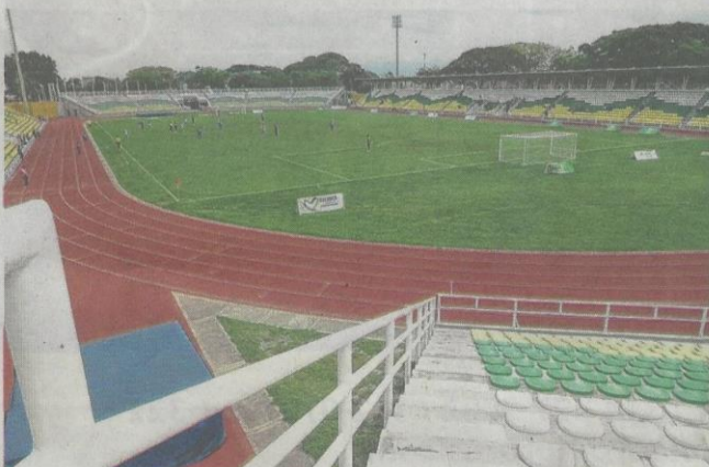
Escenarios deportivos. Las diferentes obras de infraestructura en Palmira ascienden a los cerca de $230 mil millones.
